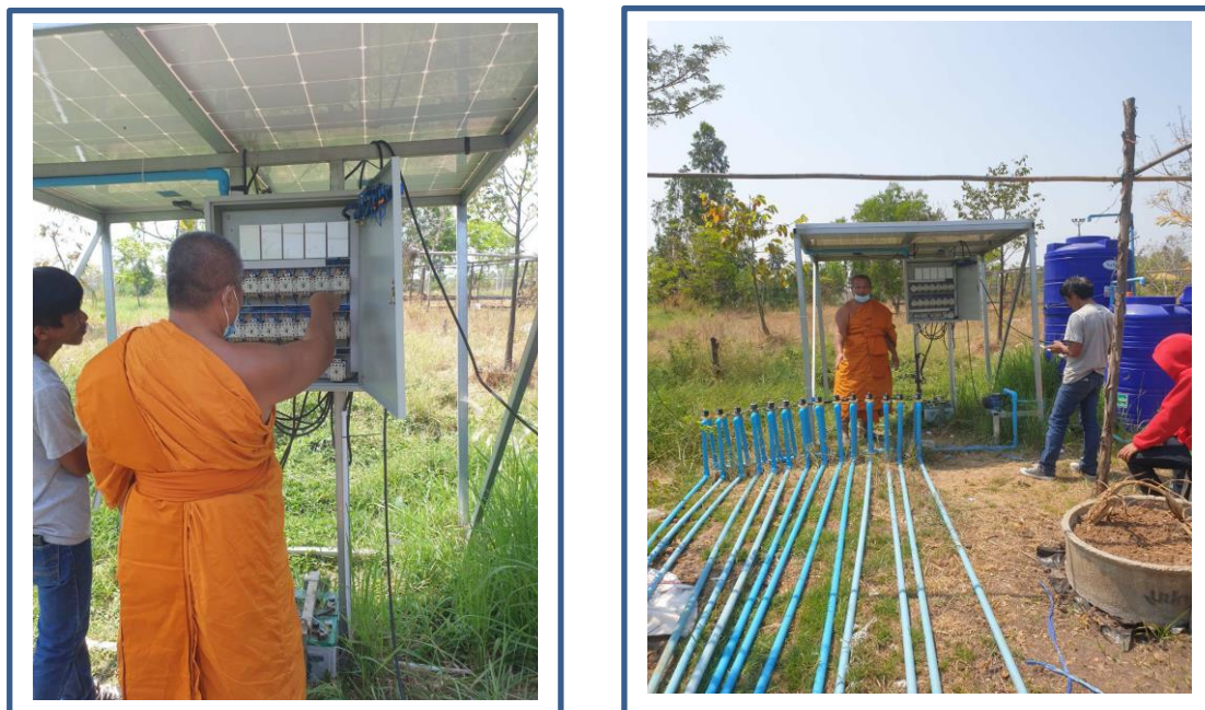
ภาพที่ 4.3 วางระบบสูบน้ำด้วยพลังงานแสงอาทิตย์
