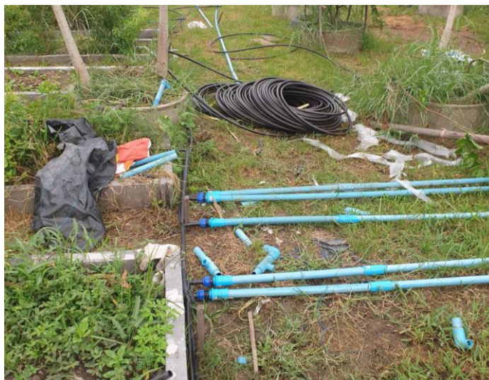
ภาพที่ 4.2 สร้างมูลค่าเพิ่มจากน้ำเสีย
