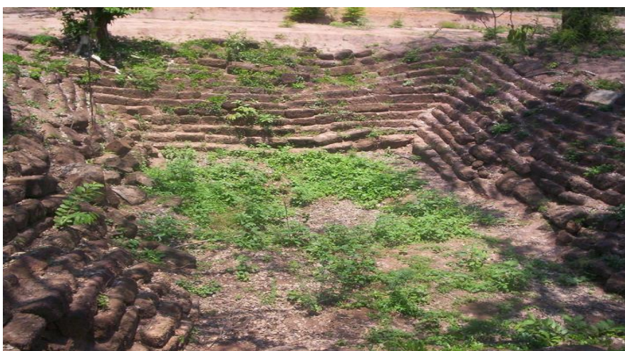
ภาพประกอบที่ ๒ สระน้ำรูปสี่เหลี่ยมผืนผ้าผนังขอบสระกรุด้วยศิลาแลงไปจนถึงพื้น
