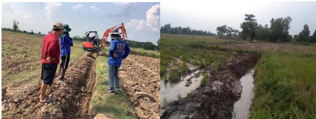
ภาพที่ ๔.๒๐ ชาวบ้านช่วยกันขุดคลองส่งน้ำแบบดิน
