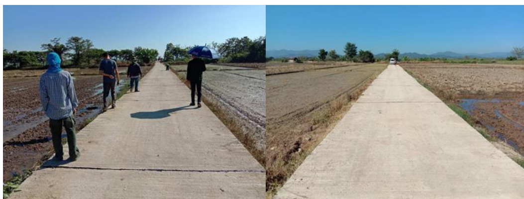
ภาพที่ ๔.๔ โครงการก่อสร้างถนนคอนกรีตเสริมเหล็ก
