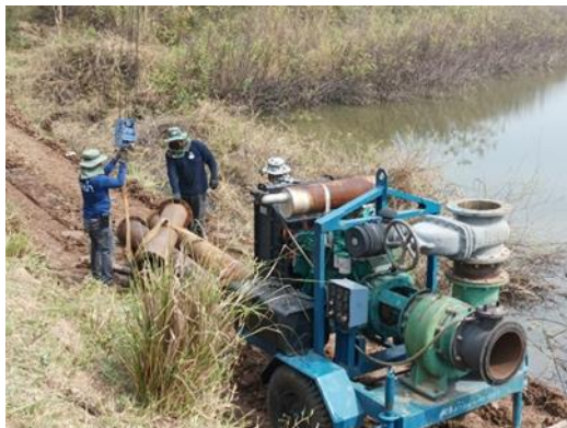
ภาพที่ ๔.๔๕ ติดตั้งเครื่องสูบน้ำที่ยืมจากสนง.ทรัพยากรน้ำภาค ๙
