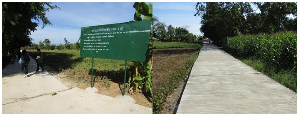
ภาพที่ ๔.๓ โครงการก่อสร้างถนนคอนกรีตเสริมเหล็ก
