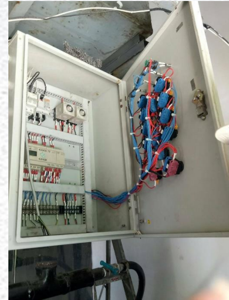
กล่องควบคุมระบบการเผาไหม้และการจ่ายสารวิมุตติ
